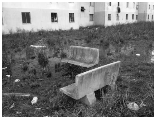
Figura 3. Esgoto a céu aberto em área interna do Jardins do Obelisco. Fonte. Os autores.
